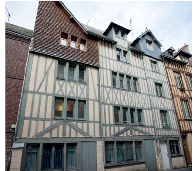
-la réhabilitation des bâtiments existants, et leur extension ou surélévation.
