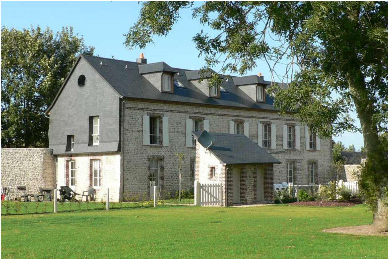
Vattetot sur Mer Xavier Tiret Réhabilitation d'une maison en gîtes
