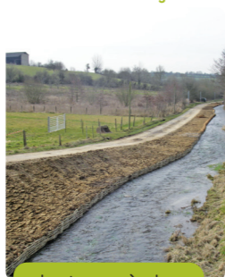
Juste après les travaux
