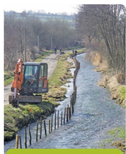
Pendant les travaux
